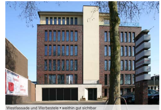
Westfassade und Werbestele • weithin gut sichtbar
